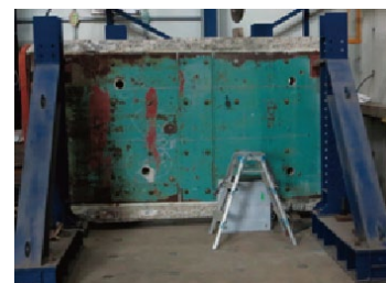
【図1】高架橋床版サンプル
