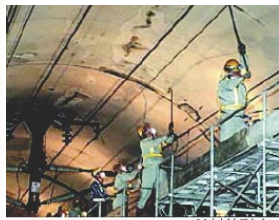
【図1】現在行われているトンネル内コンクリート検査
