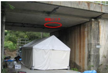
【図1】第2滝が谷橋梁での実験。丸印が探傷エリア
