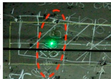
【図2】新幹線トンネル内のコンクリート欠陥箇所(表面クラック部分が小さく落下する危険性はない)
