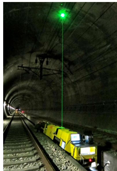
【表紙写真】山陽新幹線トンネル内での中央通路走行型レーザー検査装置（JR西日本との研究）
