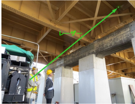
【図2】計測時の様子(レーザー入射角を鋼板平面に対して45度にして計測)
