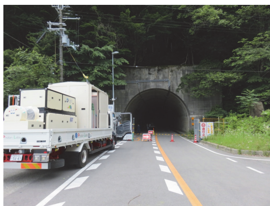
図5. 天王第一トンネル
