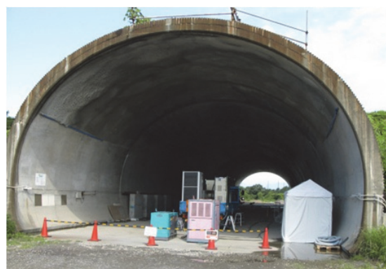
図 3. 模擬トンネル外観
