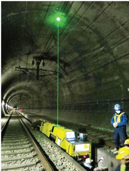
図5 新幹線トンネル内でのレーザー検査装置
