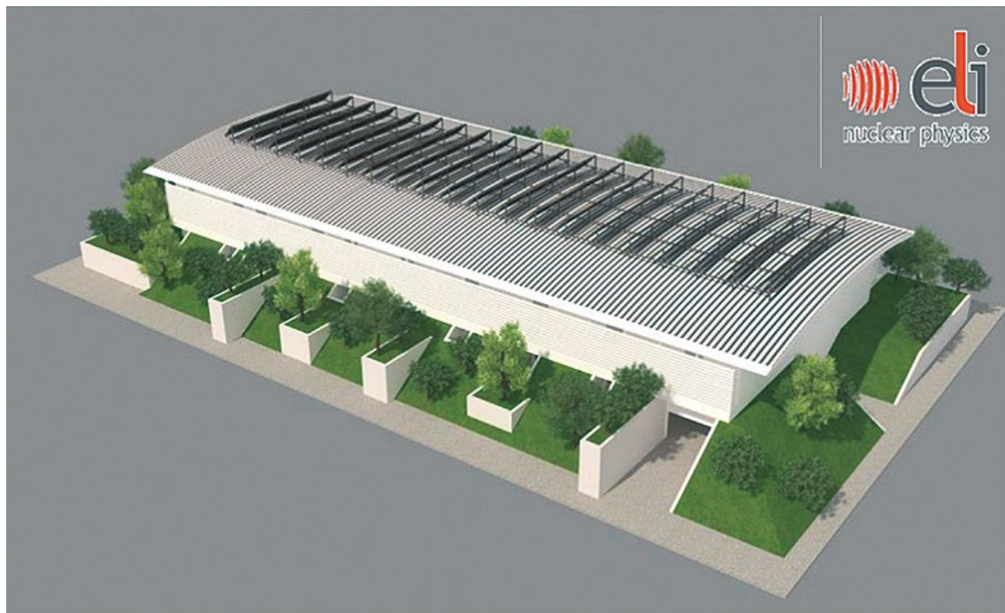
【表紙図】ELI-NPに併設される光学センター外観図 全長70m、奥行30m、高さ13mの2階構造で大型光学素子製造設備は1階、製造した素子の形状、光学特性の評価装置は2階に配置される
